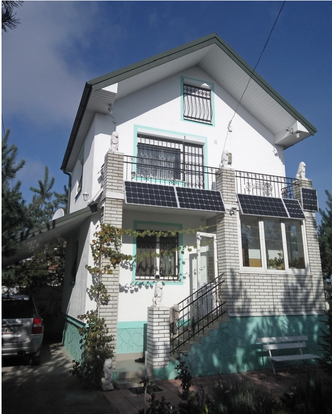
Рис. 3. Сонячна електростанція на приватному будинку потужністю 0,7 кВт*год* *(Фото та монтаж Шевчука Я.В.)
