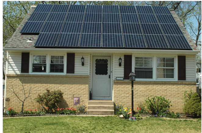
Рис. 4. Сонячна електростанція на приватному будинку потужністю 10 квт. 31 сонячна панель від фірми Sunpower по 330 Вт*
