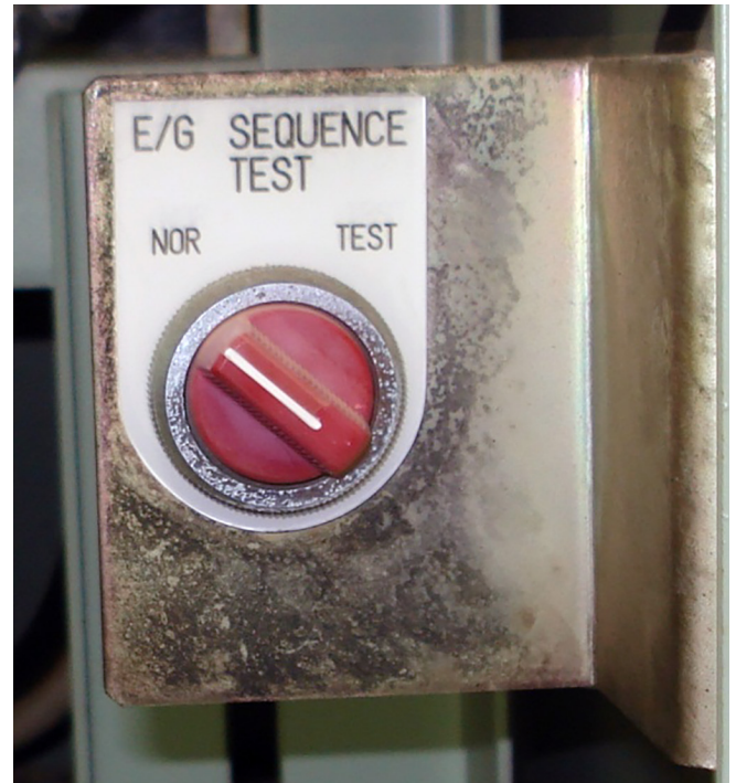
Рис. 5. Перемикач перевірки автозапуску АДГ (E/G SEQUENCE TEST — NOR/TEST)
