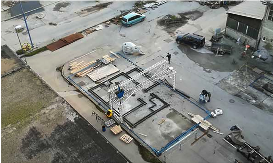
Рис. 1. 3D-принтер Icon Vulcan II (США)
