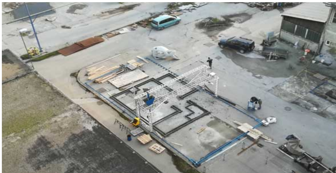
Рис. 1. 3D-принтер Icon Vulcan II (США)
