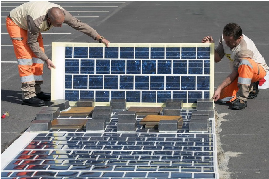
Рис. 3. Ділянка автомобільної дороги, вкрита сонячними батареями
