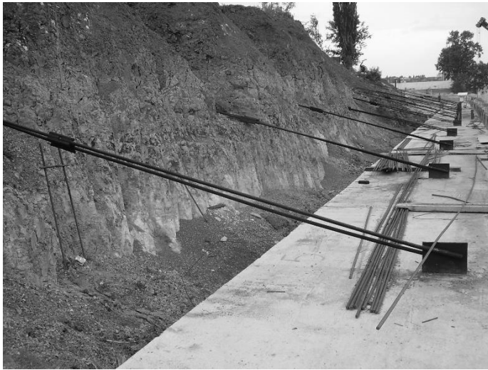
Рис. 2. Влаштування анкерних тяжів на підпірній стіні
