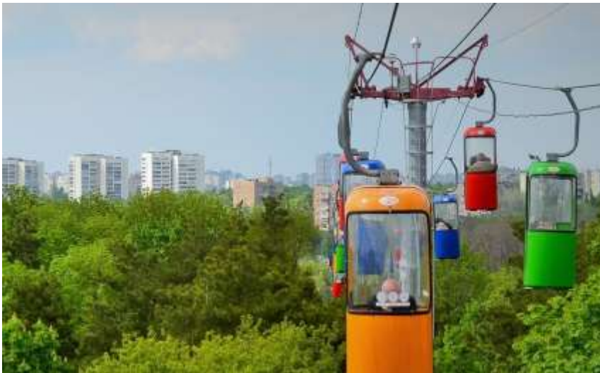
Рис. 3. Харківська канатна дорога
