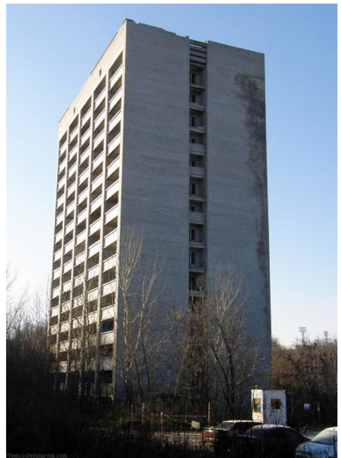
Рис. 1. Фото аварийного здания
