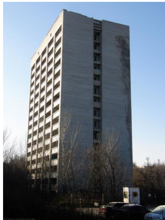
Рис. 1. Фото аварийного здания
