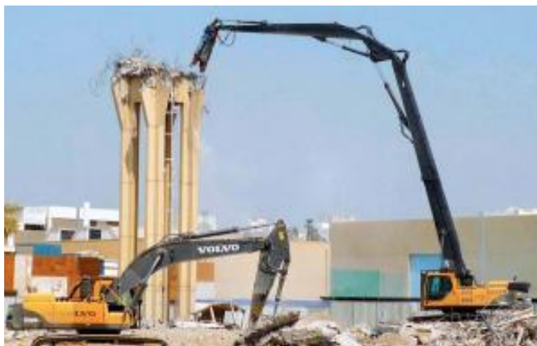
Рис. 6. Экскаватор с удлиненной стрелой с навесным оборудованием - гидробоицы (справа), экскаватор с обычной стрелой (слева)
