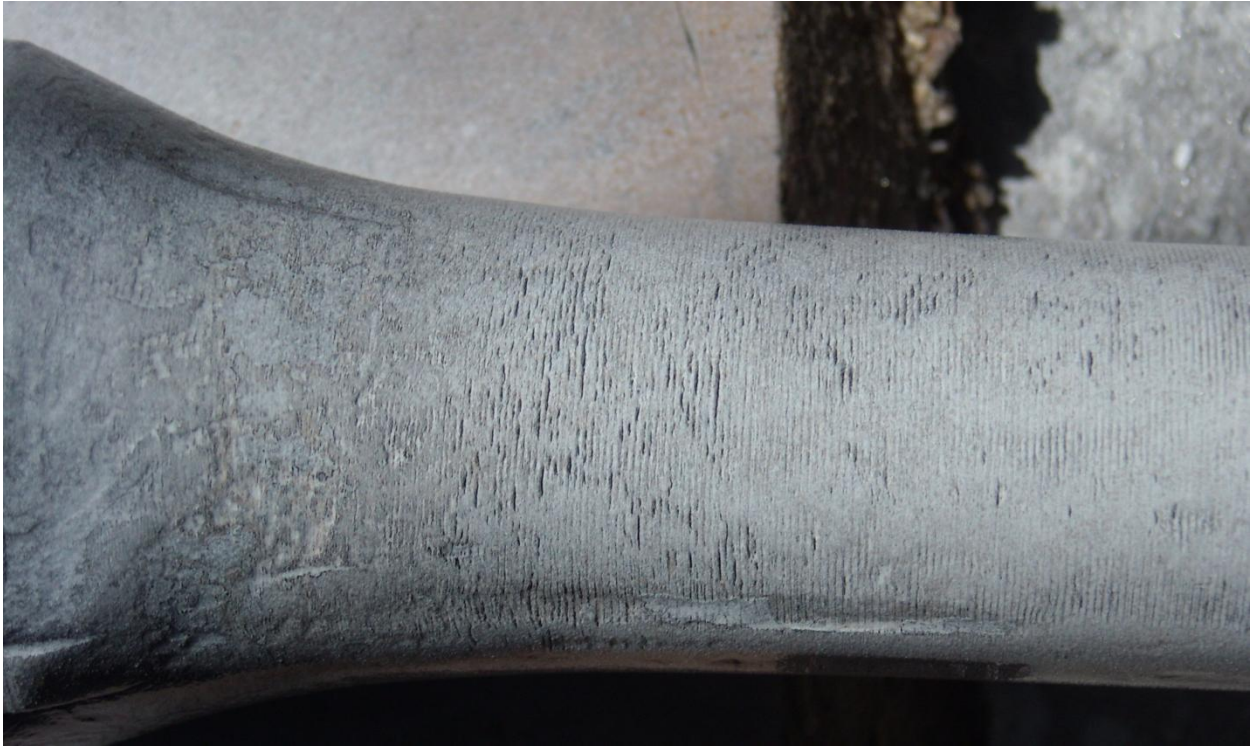
Рис. 4. Тріщини втоми, утворені в тілі штанг після випробувань при змінному напруженні \sigma=140 МПа
