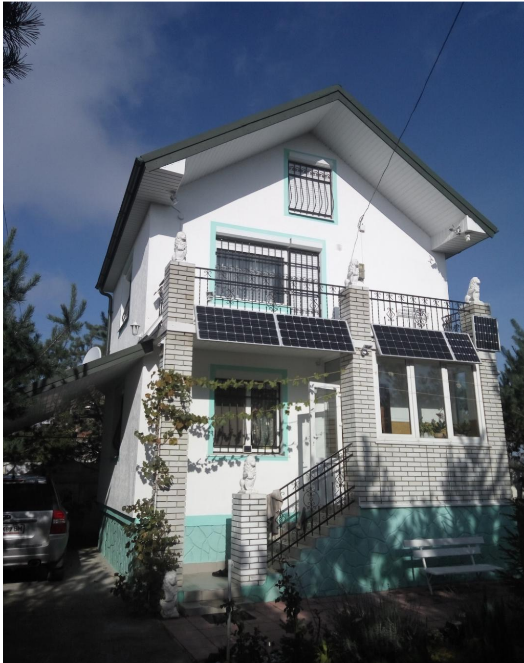
Рис.3. Сонячна електростанція на приватному будинку потужністю 0,7 кВт*год*
