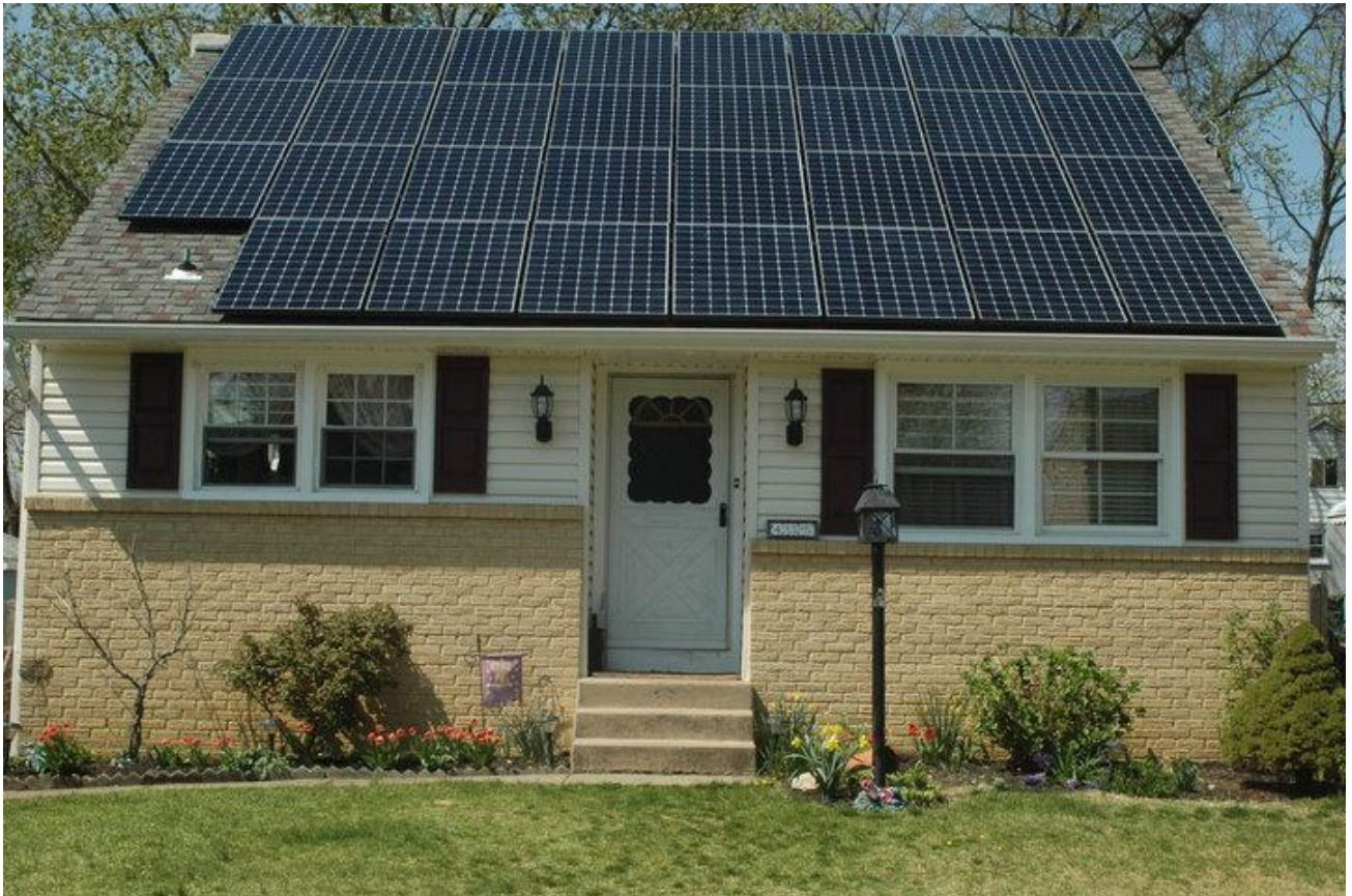
Рис. 4. Сонячна електростанція на приватному будинку потужністю 10 кВт. 31 сонячна панель від фірми Sunpower по 330 Вт* (Фото: [10]).
